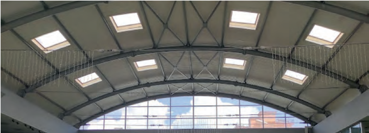
VISTA INTERNA DELLA COPERTURA
