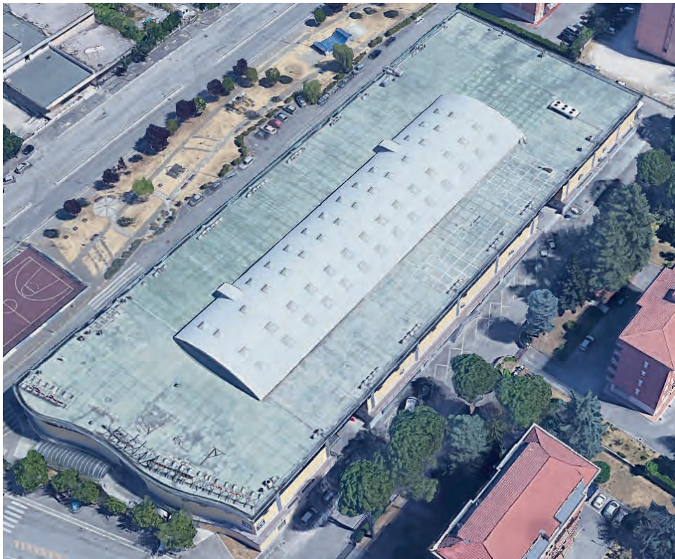
VISTA AEREA DELLA COPERTURA
